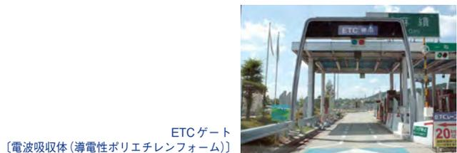
ETCゲート [電波吸収体 (導電性ポリエチレンフォーム)]
