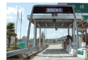
ETC ゲート [電波吸収体 (導電性ポリエチレンフォーム)] ETC gate [radio wave absorber (conductive polyethylene foam)]
